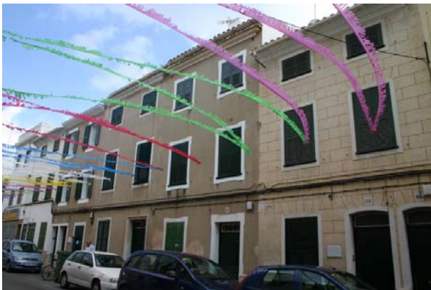
Fig. 7 Calle mahonesa del Cos de Gracia. Es un buen ejemplo del desarrollo urbanístico del siglo XVIII, en Mahón. Presenta imagen urbana y tipología arquitectónica deudora de las influencias británicas georgiano-palladianas en Menorca
